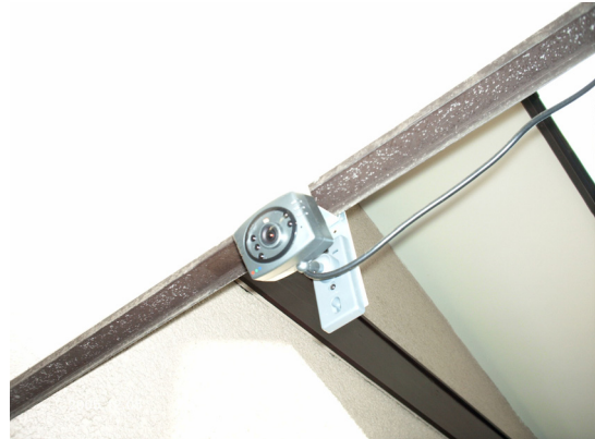
図 2-1. カメラ設置状況(設置例 2)
