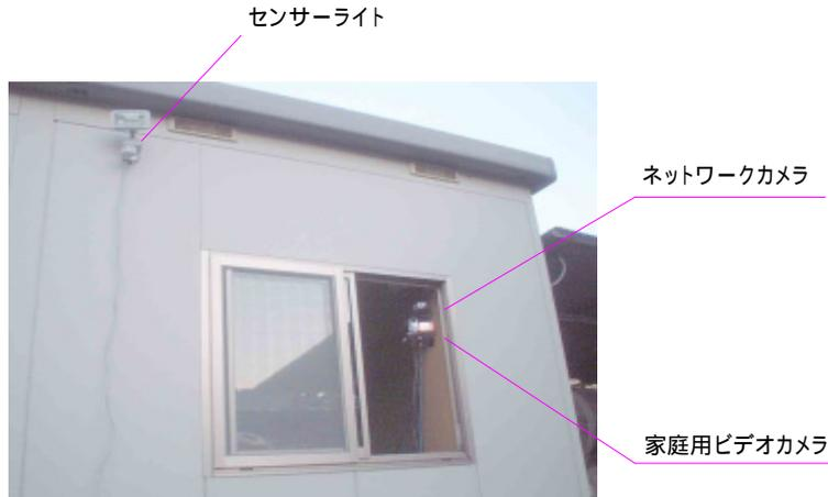
「代理EYE」及び「代理EYE FTP」を使用して、実際に工事事務所のパソコンにカメラを接続してみました。カメラ設置場所は、外灯が近くになく夜間は暗いので、カメラ設置場所のそばにセンサーライトを取り付けました。
